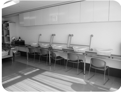
改修後の脱衣室です。縦の手すりが加わり、より安全に立っていただけるようになりました。
