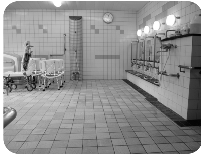
一般浴室内です。手すりの造設と壁・床のタイルの貼り替えを行いました。
